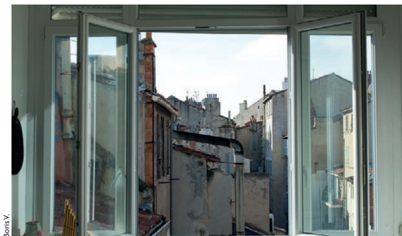
Plus de deux millions de Français vivent dans des logements présentant des défauts graves.
